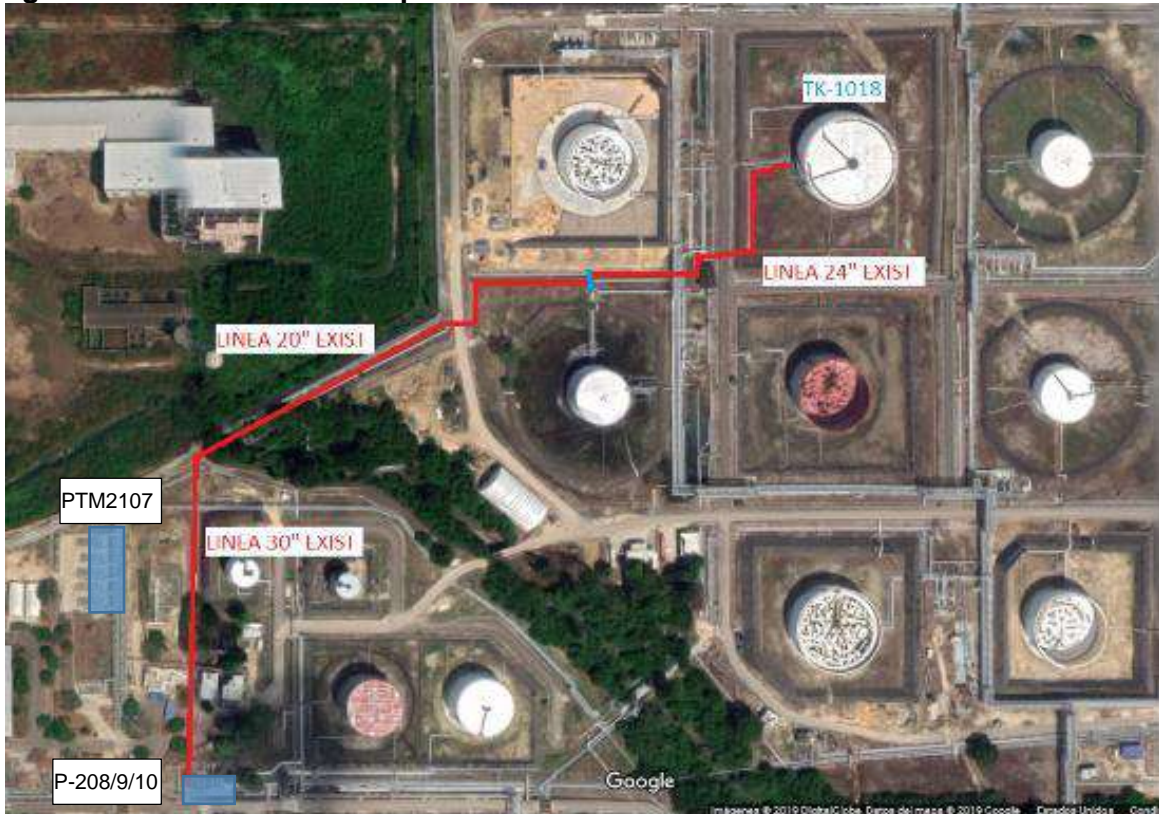
Figura 2-15 Adecuaciones exportación de Gasóleo
